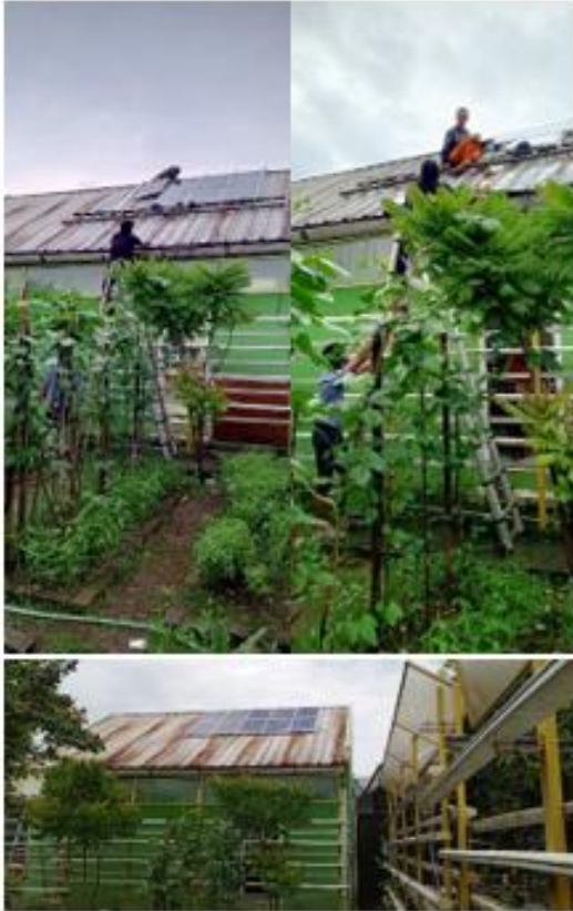
Gambar 2: Proses pemasangan dan hasil instalasi panel surya di atap kantin
