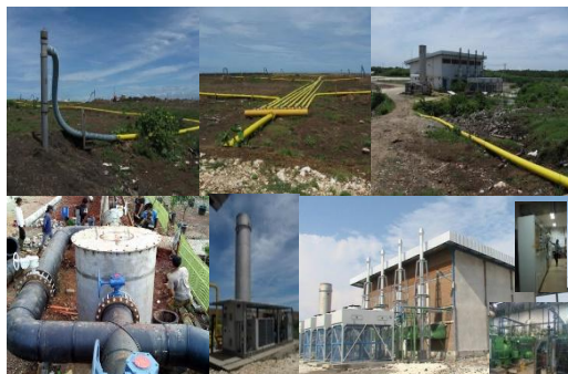
Gambar 2.6 PLTSa Landfill Bantar Gebang Sumber: [9]
