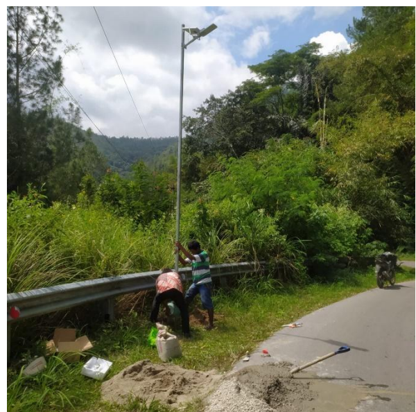
Gambar 1: Pemasangan Panel Surya
