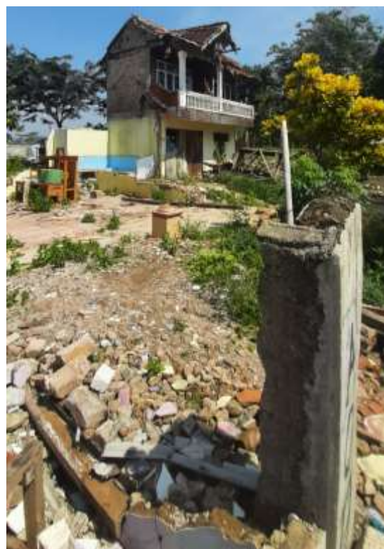
Gambar 9: Kondisi wilayah Zona Merah yang hancur akibat gempa Cianjur di Desa Sarampad
