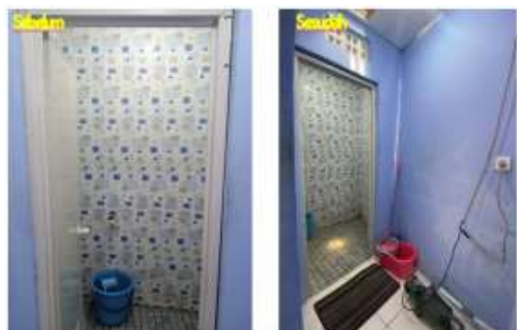
Gambar 5 dan 6. (kiri) foto toilet sebelum (kanan) foto toilet sesudah
