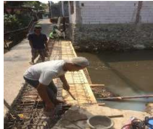
Gambar 13. Pekerjaan pembesian pada Jembatan Cawang
