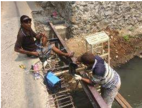
Gambar 12. Pengarahan untuk Pekerjaan Pembesian
