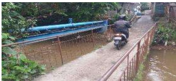
Gambar 1. Kondisi jembatan penyebrangan Cawang eksisting
