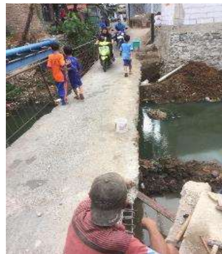
Gambar 10. Persiapan Konstruksi Pelebaran Jembatan Cawang
