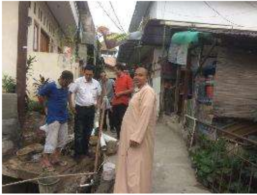
Gambar 11. Pendampingan oleh Tim PKM pada proses konstruksi
