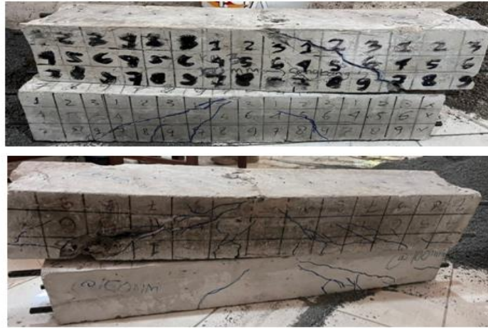
Gambar 11. Tampak Depan dan Belakang Pola Retak Pada Balok B1 dan Balok B2
