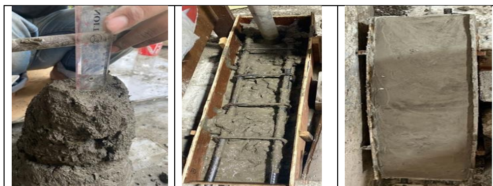
Gambar 5. Proses Pengecoran dan Uji Slump Beton
