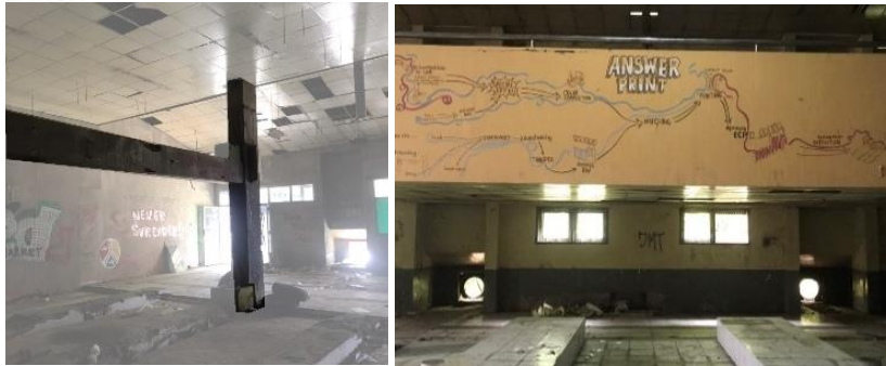
Gambar 8. Struktur balok dan ventilasi untuk proses kimia
