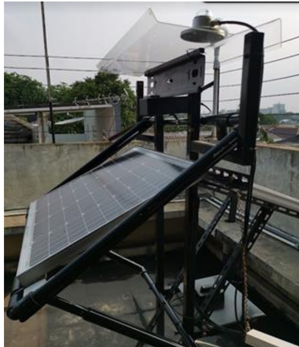
Gambar 2. Kondisi pemasangan panel surya
